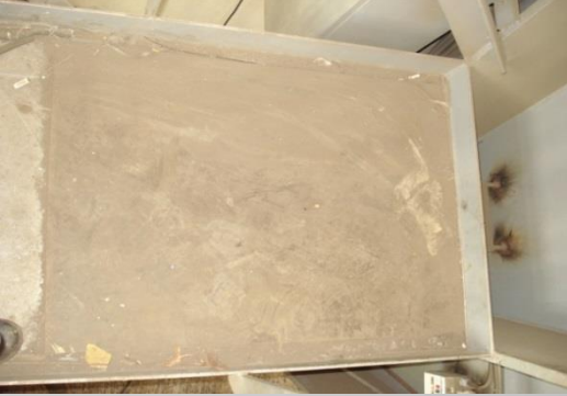
Sabit Panolar için İzole halı Uygulaması
