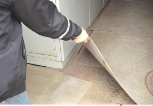
Sabit Panolar için İzole halı Uygulaması
