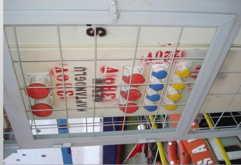
Küçük gerilim için kullanılan 24 V Pano çıkışları
