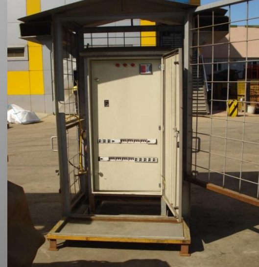
Seyyar Panolar için İzole halı Uygulaması
